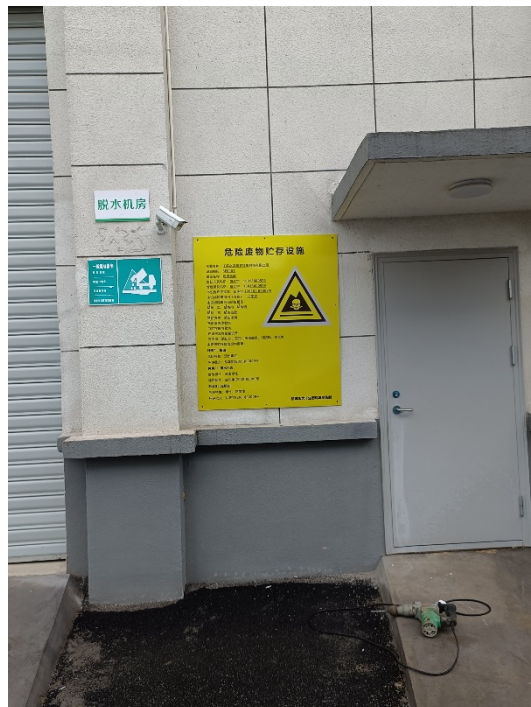
危废仓库外部
