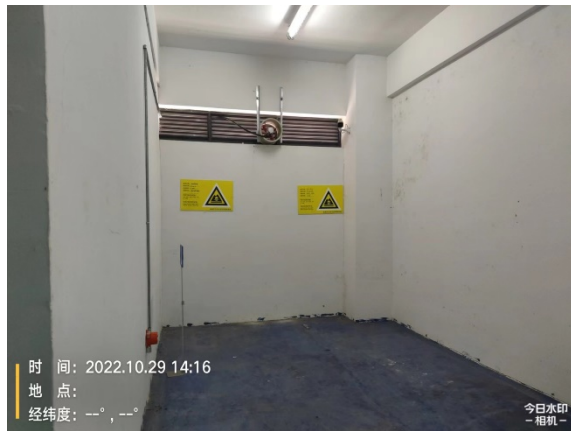
危险废物仓库
