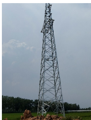
风机吊装、集电铁塔架设
