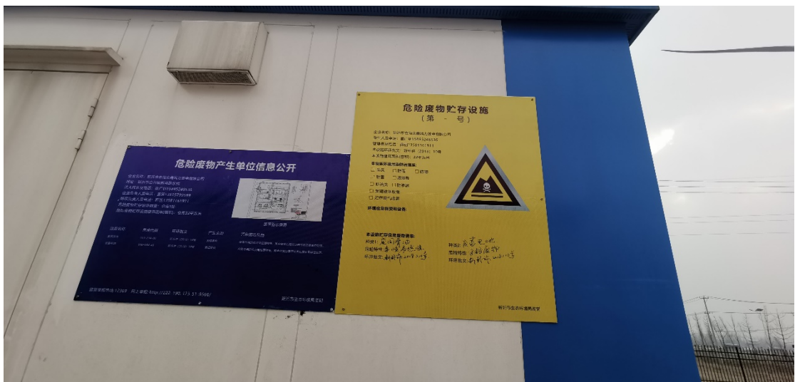
危废间外部标识牌
